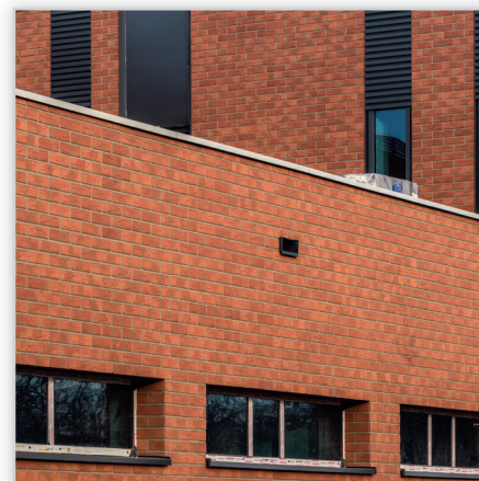
Fasada basenu została wykonana przy użyciu materiałów firmy Elastolith .
